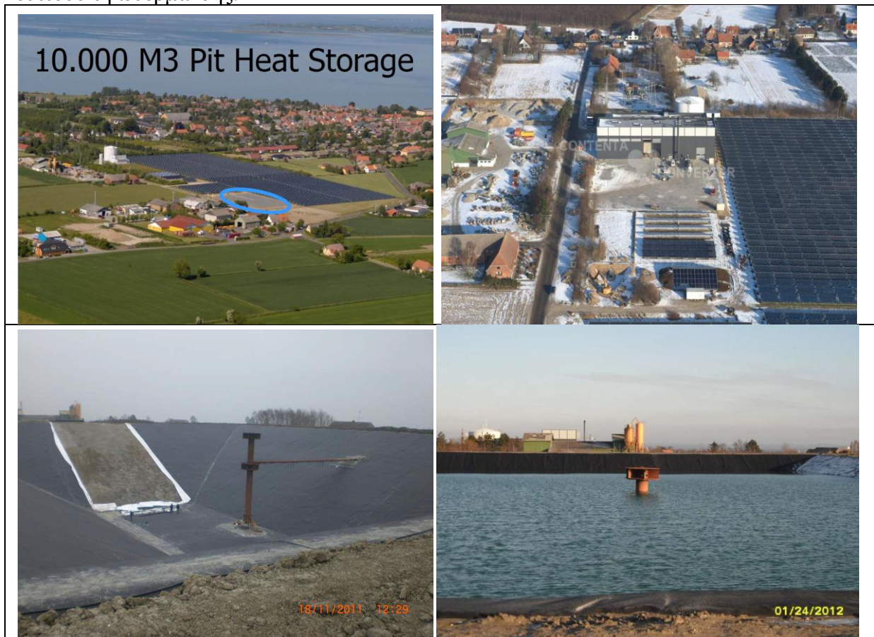
Εικόνα 1.4: Ηλιακό πεδίο και διεποχική αποθήκευση θερμότητας στην πόλη του Marstal στη Δανία 19
