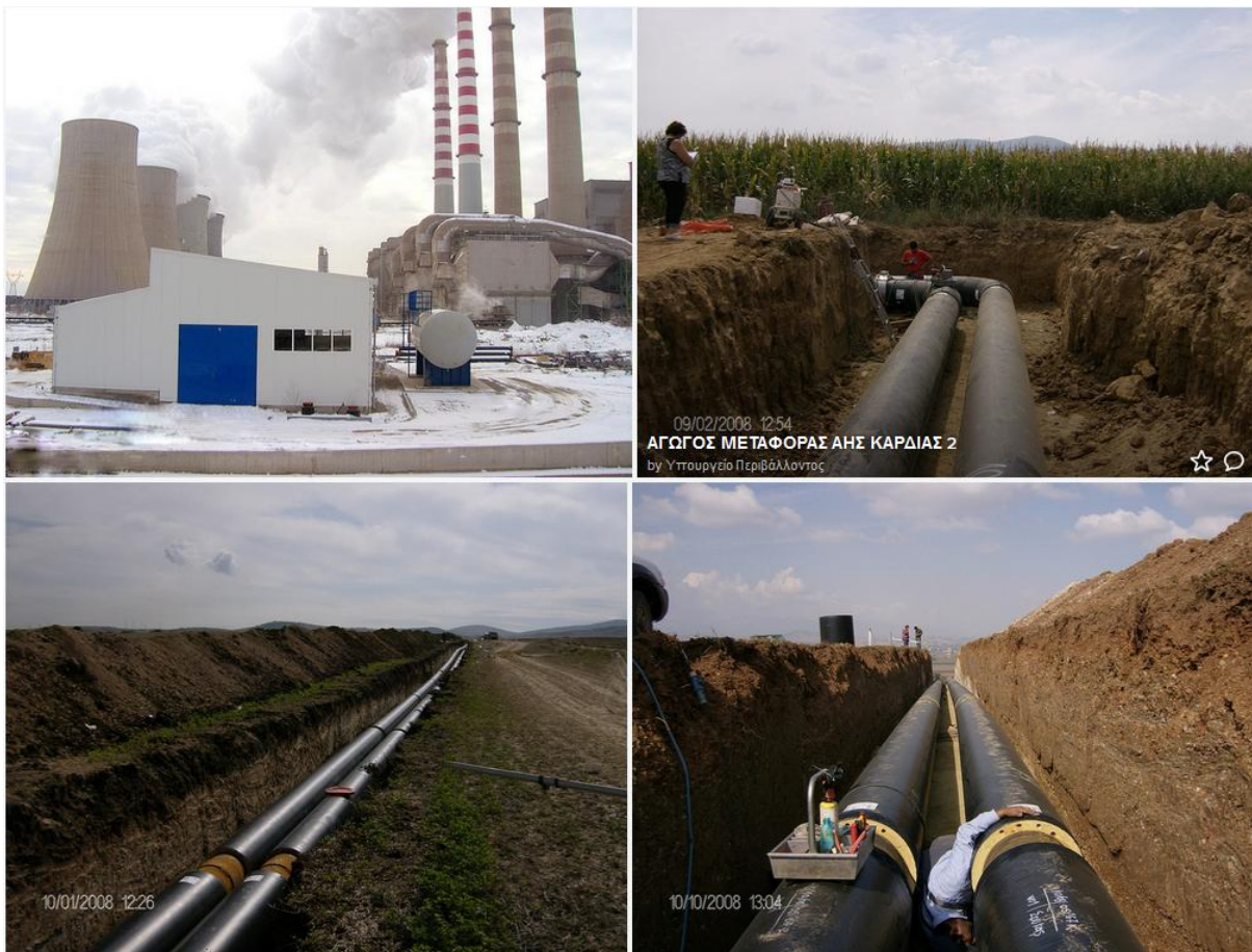
Εικόνα 1.1: Τηλεθέρμανση Πτολεμαΐδας - Σύνδεση με τον ΑΗΣ Καρδιάς 1
