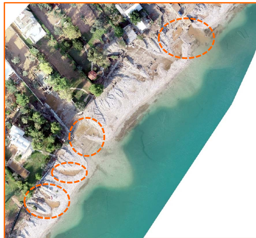
Εκβάθυνση παραλίας και απομάκρυνση ιζημάτων
