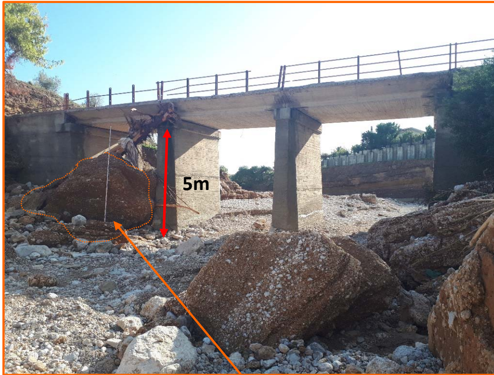
Μετακίνηση ογκολίθου διαμέτρου 6 μέτρων
