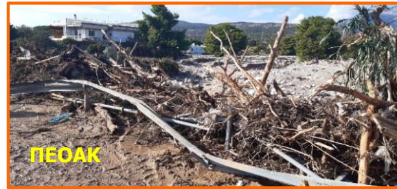
Συσσώρευση κορμών δέντρων ανάτη της γέφυρας συνολικού μήκους \approx 52\text{m}
