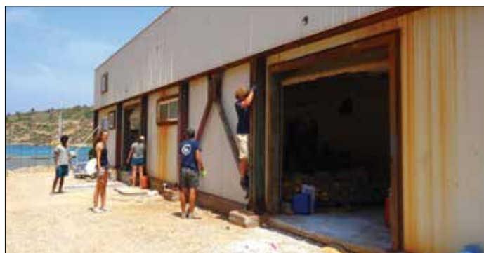
Κτήριο Καταφυγίου Θαλάσσιας Ζωής Αιγαίου 2016
