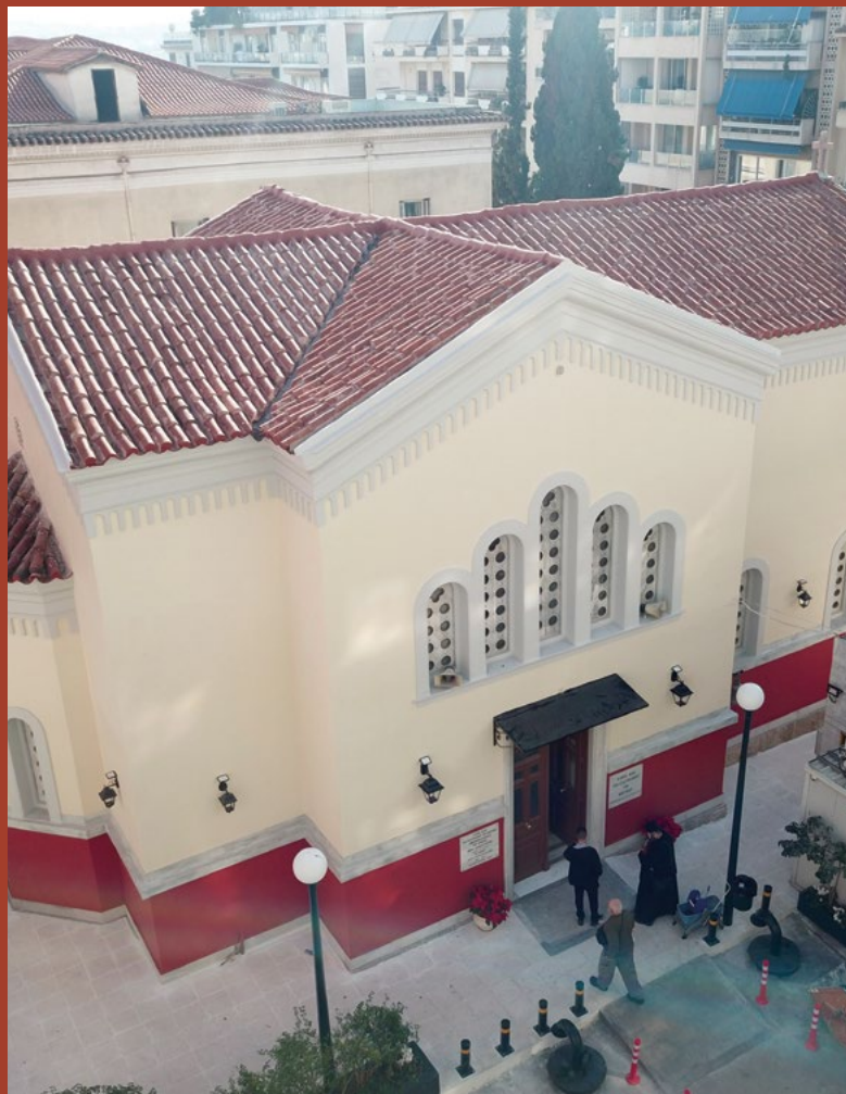
Μετά την ανακαίνιση
