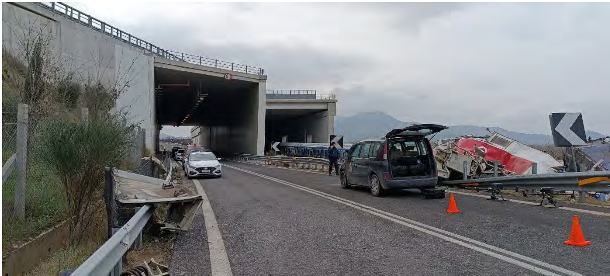
Φώτο 21. Συντρίμια και στην απέναντι πλευρά του δρόμου από την ηλεκτρ/μαξα 120-022
