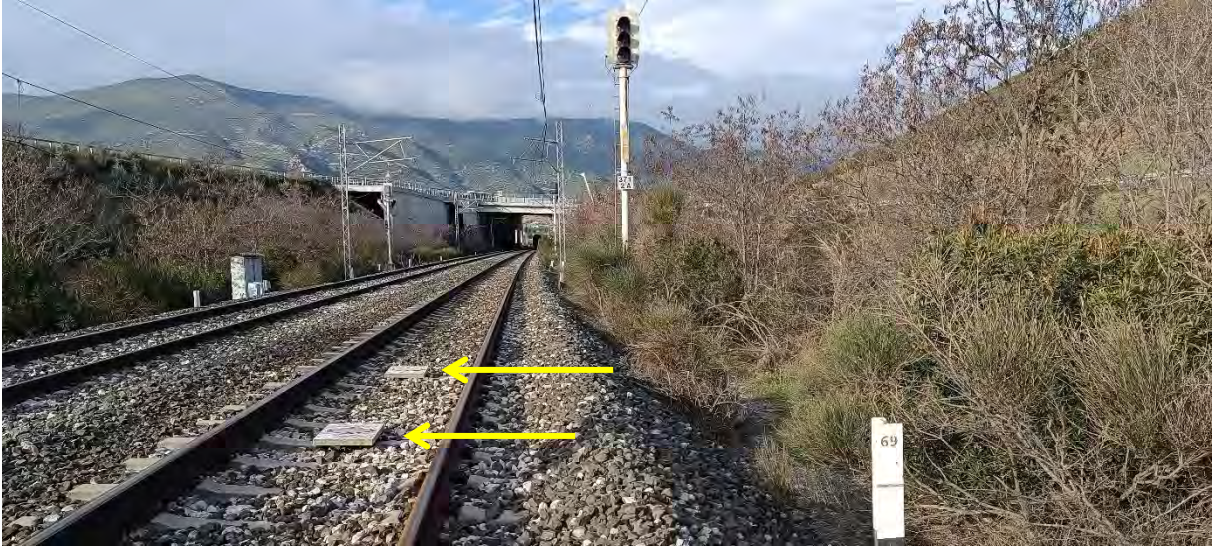
Φώτο 75. Εγκατεστημένοι ραδιοφάρου (Balises) επί της γραμμής πλησίον του δυστυχήματος
