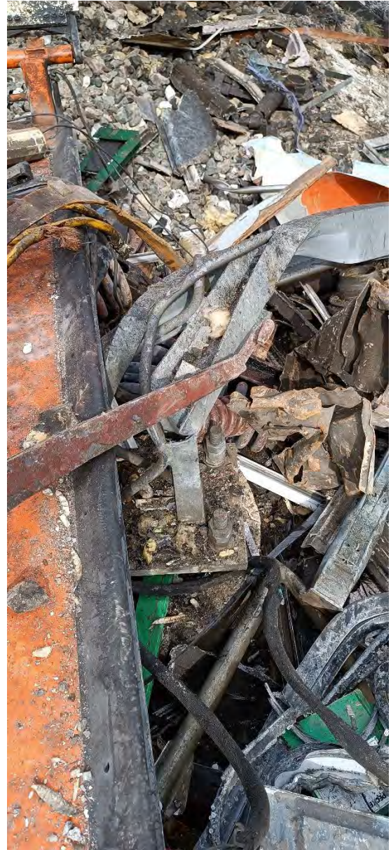
Φώτο 66 Καταστροφή και της βάσης του μεταλλικού πύργου συγκράτησης καλωδίων
