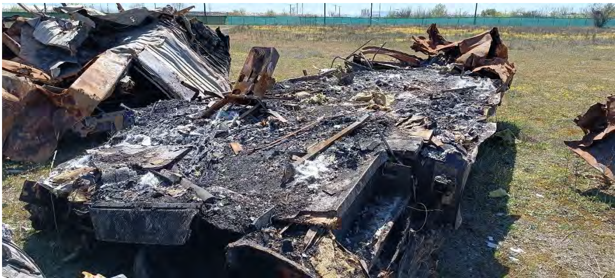
Φώτο 36. Τμήμα του κυλικείου που κάηκε ολοσχερώς
