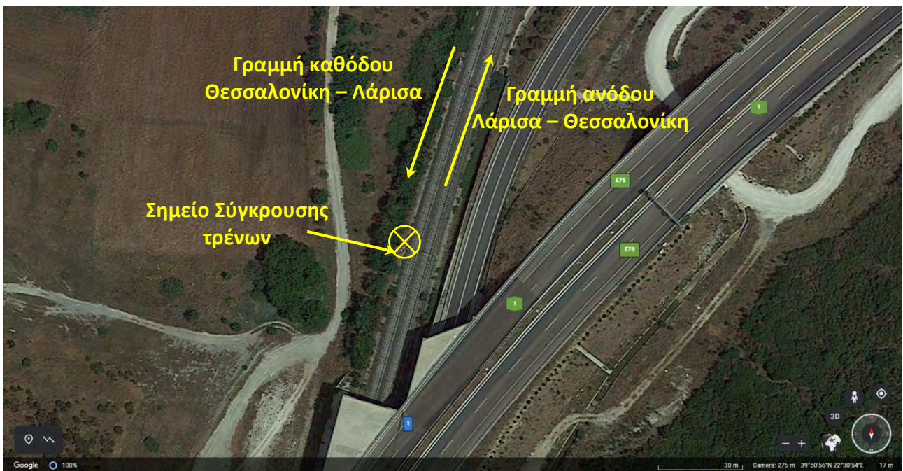
Εικόνα 2. Τοποθεσία δυστυχήματος, εικόνα από Google Earth.
